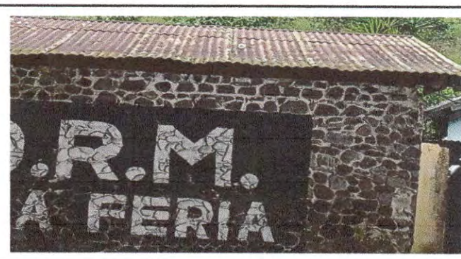
Foto 6: Sustrución de canales y bajadas de agua pluvial de pvc.
