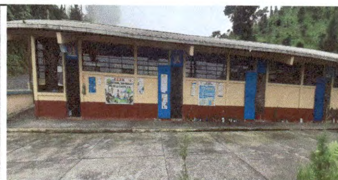
Foto 18. Pintura en muros interiores y exteriores.
