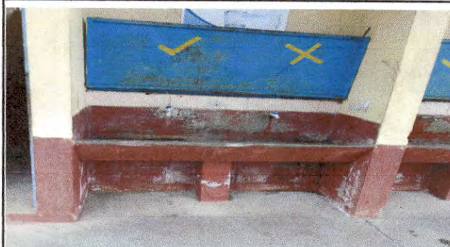
foto 16: Sustitución de azulejo.
