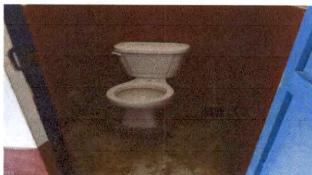
Foto 15: Sustitución de accesorios inodoro.
