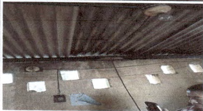
Foto 7: Reparación del sistema eléctrico.
