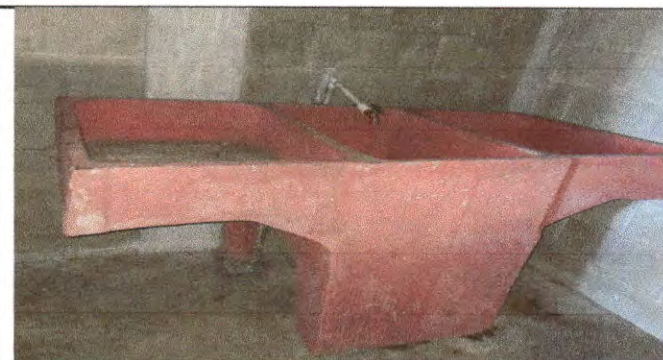
Foto 17. Sustitución de pila plástica de un lavadero. (incluye sistema de drenaje y conexión de agua)
