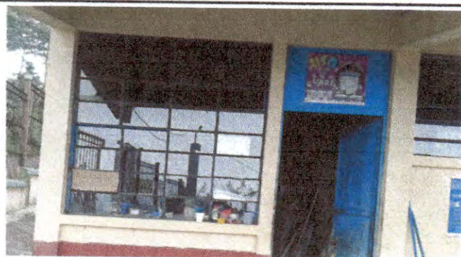
Foto 9: Mantenimiento a estructura de metal de ventana.
