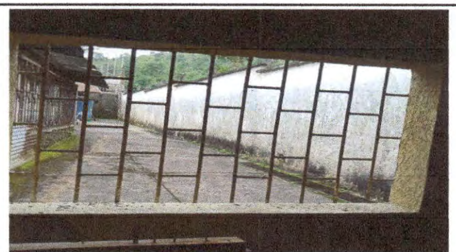
Foto 5: Sustrución de ventana de metal por ventana de pvc.
