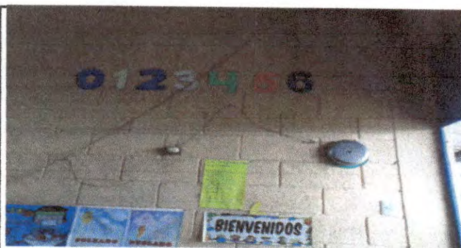
Foto 11: Reparación del sistema eléctrico más accesorios.
